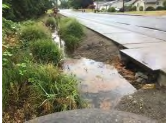
Site Photo: FA_SitePhotos-20230725-211820.jpg
