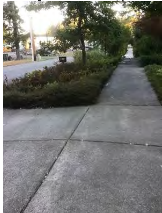
Site Photo: FA_SitePhotos-20230921-143622.jpg
