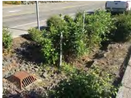
Site Photo: FA_SitePhotos-20230623-154651.jpg
