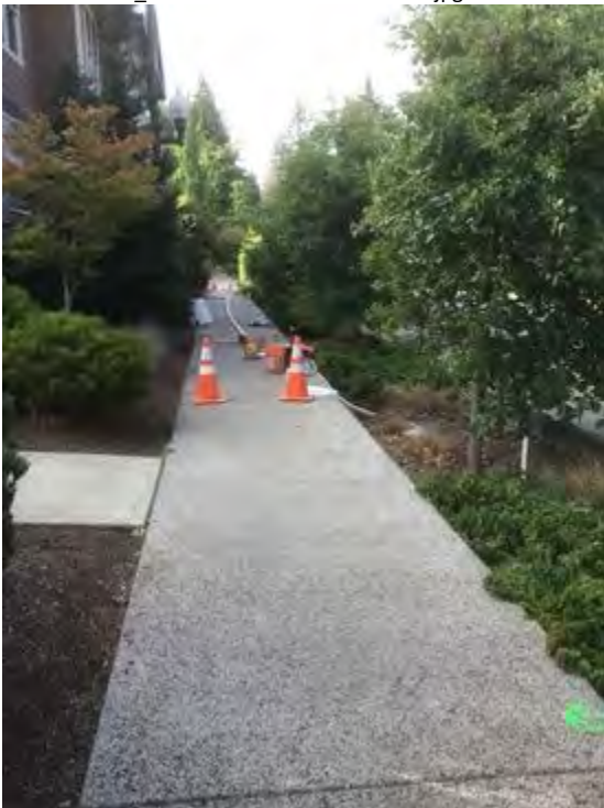
Site Photo: FA_SitePhotos-20230920-164056.jpg
